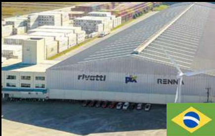
Centro de distribuição - Navegantes - SC
